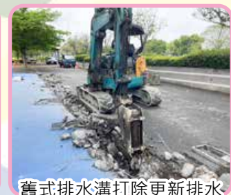
舊式排水溝打除更新排水系統改善校園積水問題
